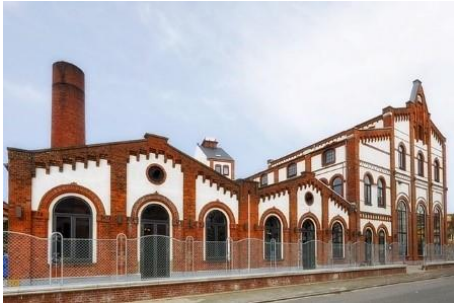
Ansicht Theodorstr. Braugasthof im ehem. Kesselhaus
